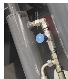
Abbildung 23. Drosselventil
